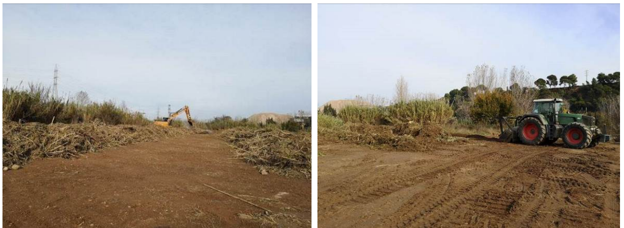
Imatges de la preparació de les piles i la trituració
