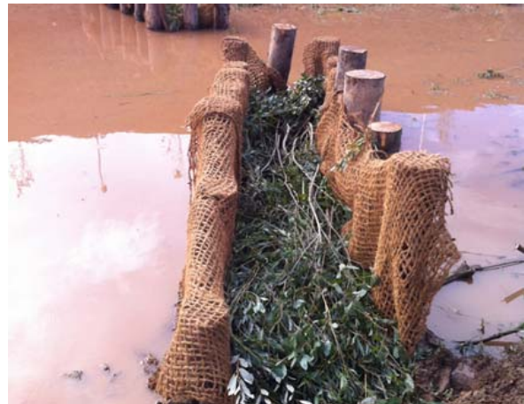
Esquema i palissada amb tronc d'arbustives en procés de construcció
