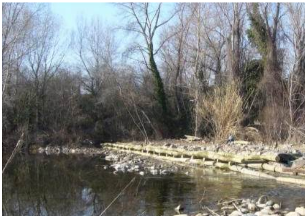
Obra a Pla dels Socs d'un deflector un cop acabada l'obra i al cap d'uns mesos
