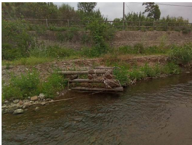
Imatges dels deflectors 1 i 2 del tram 1.2 que s'han de reconstruir
