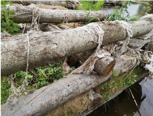
Imatges de l'estat actual dels deflectors del tram 1.2
